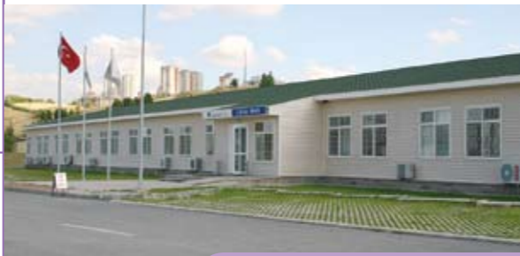
Hacettepe Teknokent 3. Ar-Ge Binası
